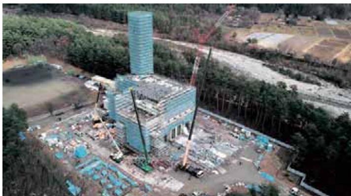
北アルプスエコパークの建設現場（11月撮影）
