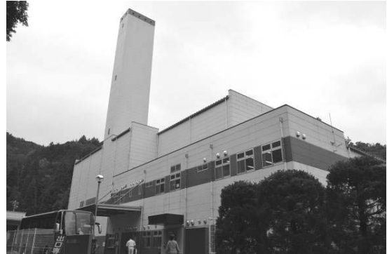
クリーンセンター外観
