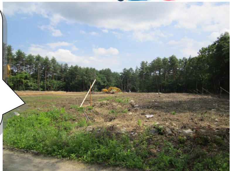
写真1 建設現場の状況(用地北側から撮影)
